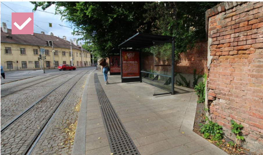
08 Nástupište a nika pre prístrešok je vhodne vydláždená rovnakou kamennou dlažbou vrátane prístupových rámp. Nástupište je jednotné a materiálovo zjednotené. Zastávka Americké námestie, Bratislava
